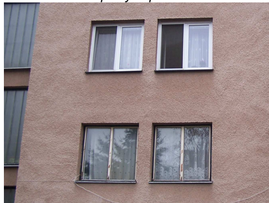
Okna původní dřevěná a nová plastová
