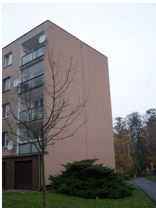
Zateplený východní štít
